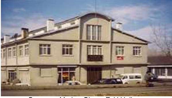
Borsamız Merkez Binası Eski Hali
