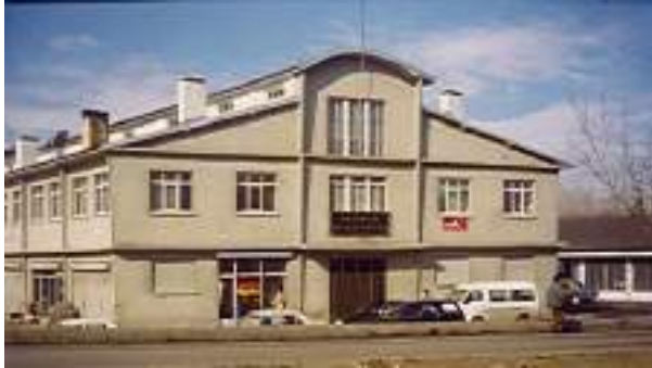
Borsamız Merkez Binası Eski Hali
