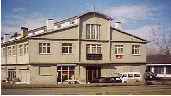
Borsamız Merkez Binası Eski Hali
