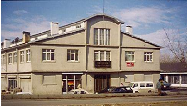
Borsamız Merkez Binası Eski Hali
